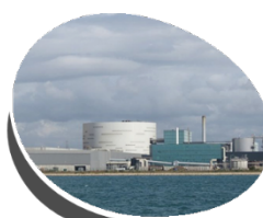
EveRé Waste treatment Fos-sur-mer
